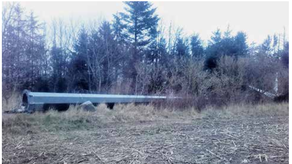
Peter Lagergaards havarede KVA-mølle.
