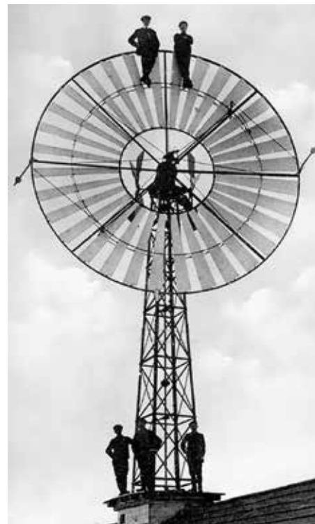
A.F.Heidemann jun. i Hjørring havde eget jernstøberi og producerede vindmøller fra 1906 til 1933. På højre og venstre side af vindrosen fra Heidemann jun. kan man se de svingvægte, der via en tynd jernkrans, som de to friske fyre står på, regulerede bladene og kantstillede dem, hvis omdrejningstallet blev for højt. (Foto: Historisk Arkiv, Vendsyssel Historiske Museum)
